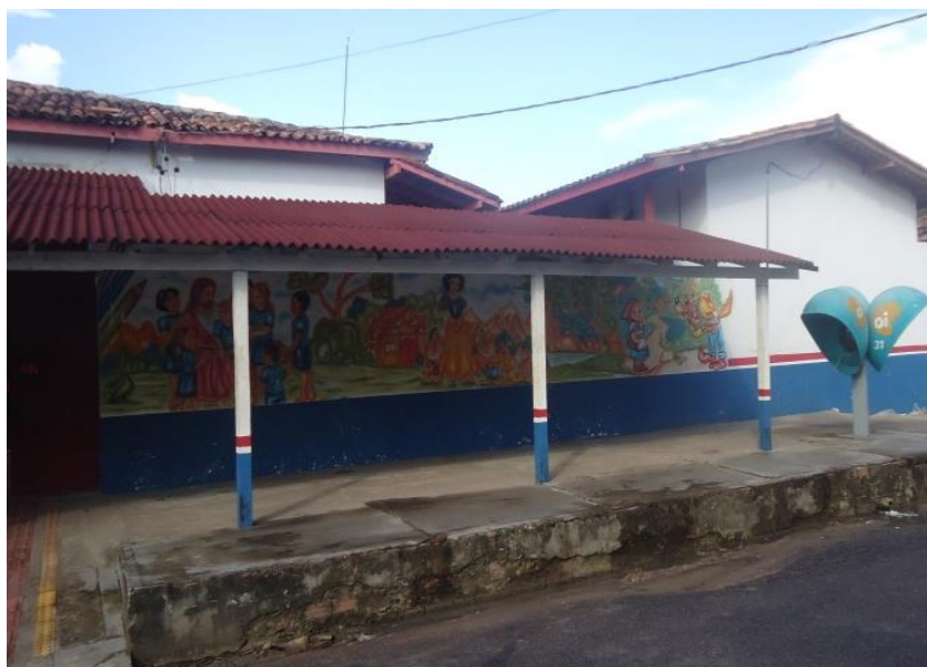
Imagem 3: Muro principal da escola (Lado direito)
